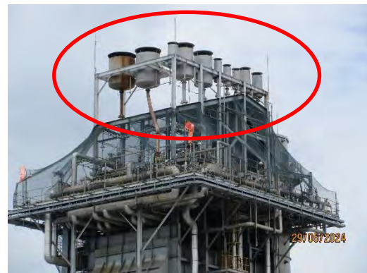
ภาพที่ 2-3 Silencer บริเวณวาล์วนิรภัยโรงไฟฟ้า (Safety Valve)
